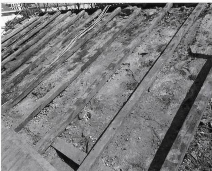
5-7. Particolari delle fasi di rimozione del manto e della listellatura
