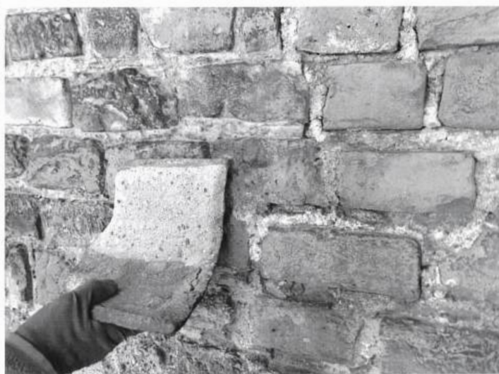
12. Campionatura della malta per la ripresa delle stilature dei giunti
