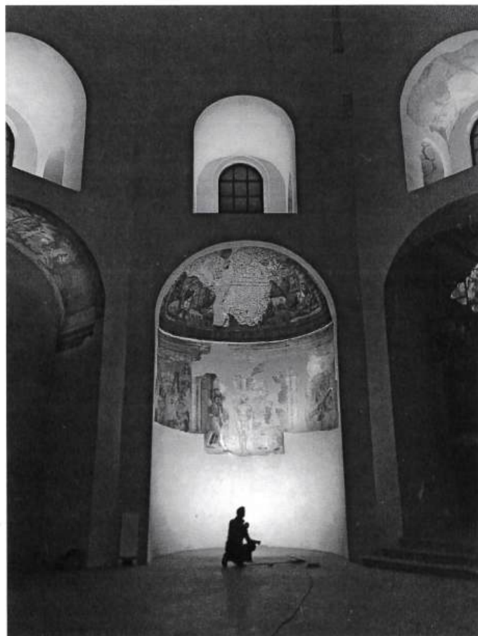
21. Particolare della fase di puntamento e sagomatura del fascio luminoso per rimanere confinato dentro l'esedra
