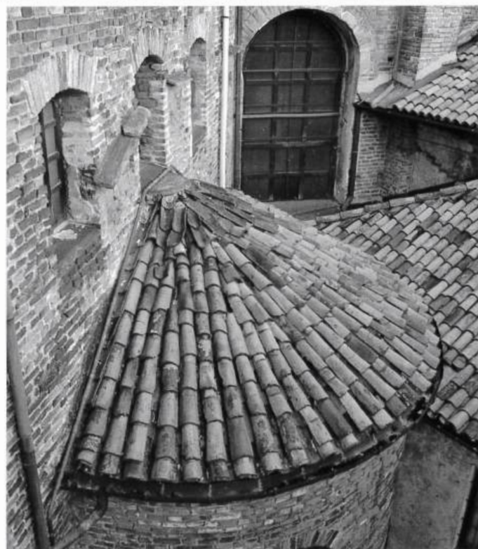
10-11. Vedute dello stato di fatto
