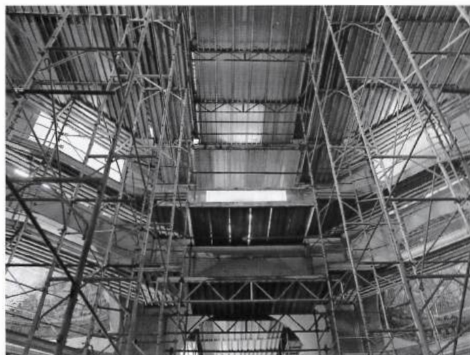
17. Veduta del ponteggio all'interno dell'ottagono
